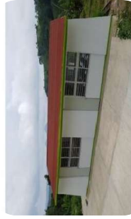
Fotografía 1.- Plantel 309 Las Pimientas Dos aulas con estructura Tipo RC de 6 x 8.00 m.
